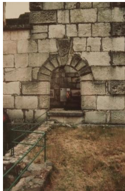
Fig. 44: Vestigios de muro y arco en casa de máquina, Museo Mina de Acosta
